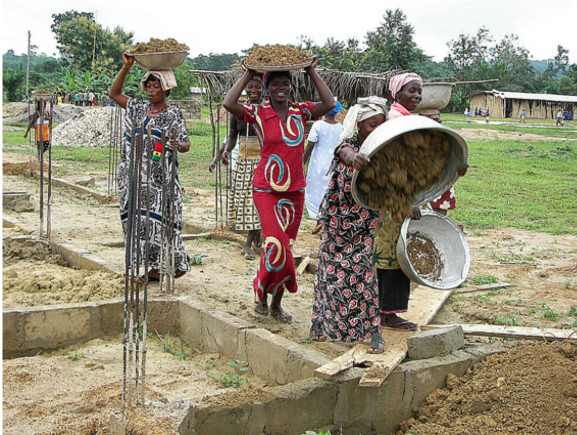
Schubkarren sind Mangelware: Grundaushub in Ntronang für den Bau der Schule.
