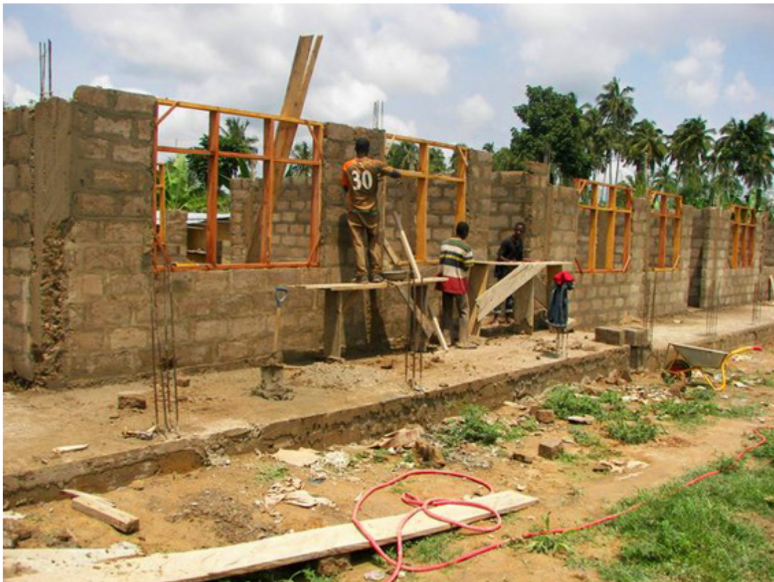
Die neue Schule nimmt Formen an.
